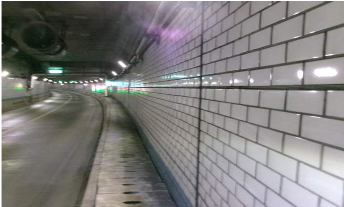
BOX구간 벽체 전경
