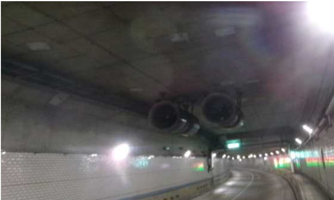
BOX구간 슬래브 전경
