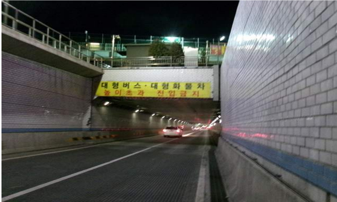
갱문 시점부 전경
